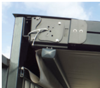
Spoj vodilice i zida
